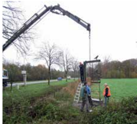
Het plaatsen van het kunstwerk
